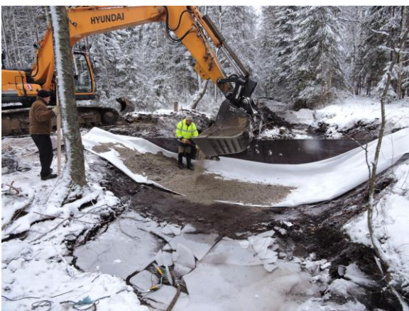
Suodatinkankaan asennus paikalleen
