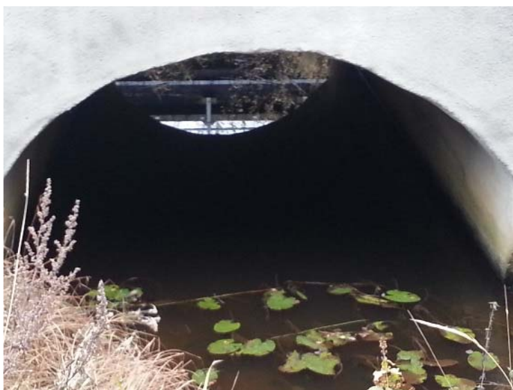
Siirin betoninen silta 21.10.2015.
