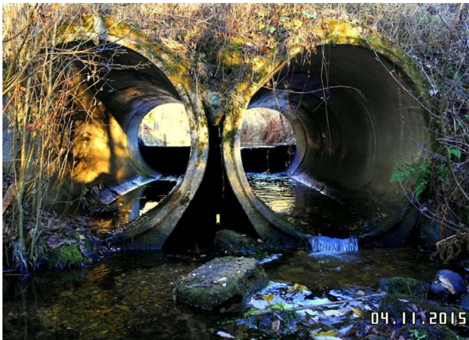
Kankaisten kylän kaksi rumpua, joissa on vaakasuuntaan asetettu patolevy. Seppo Alkula 4.11.2015.
