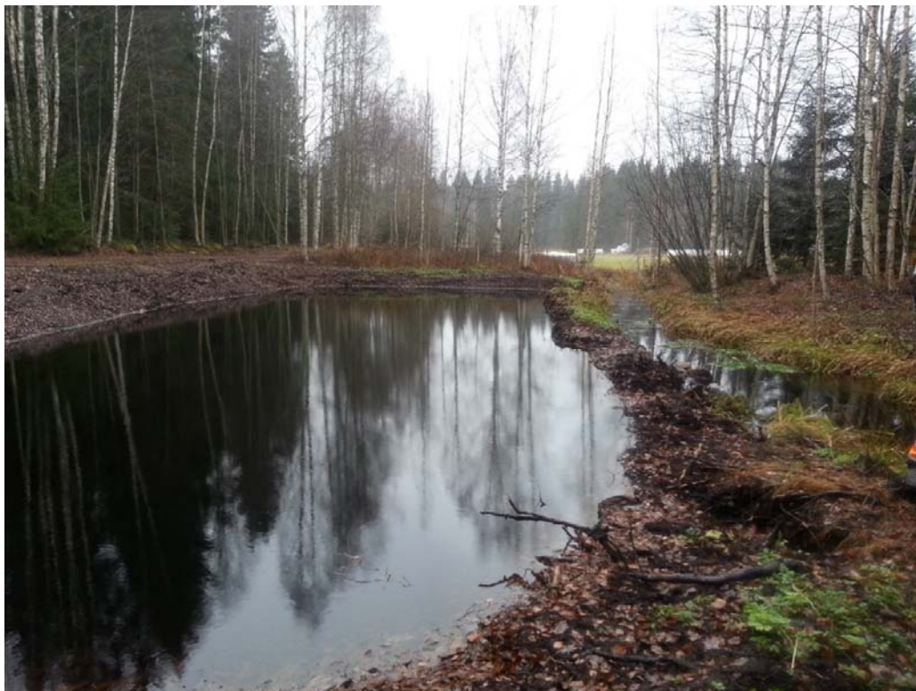
Komulahdenojan valtatie yläjuoksun puolella oleva laskeutusallas 28.10.2014.
